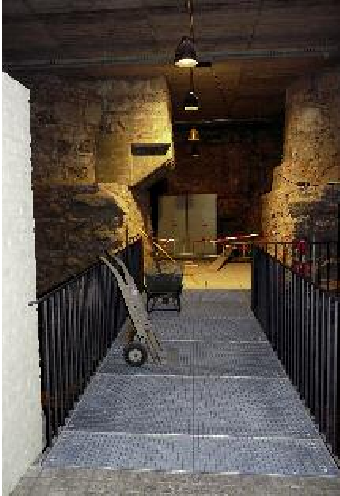
11. Neuer Gittersteg im Bereich der Domgrabung.
