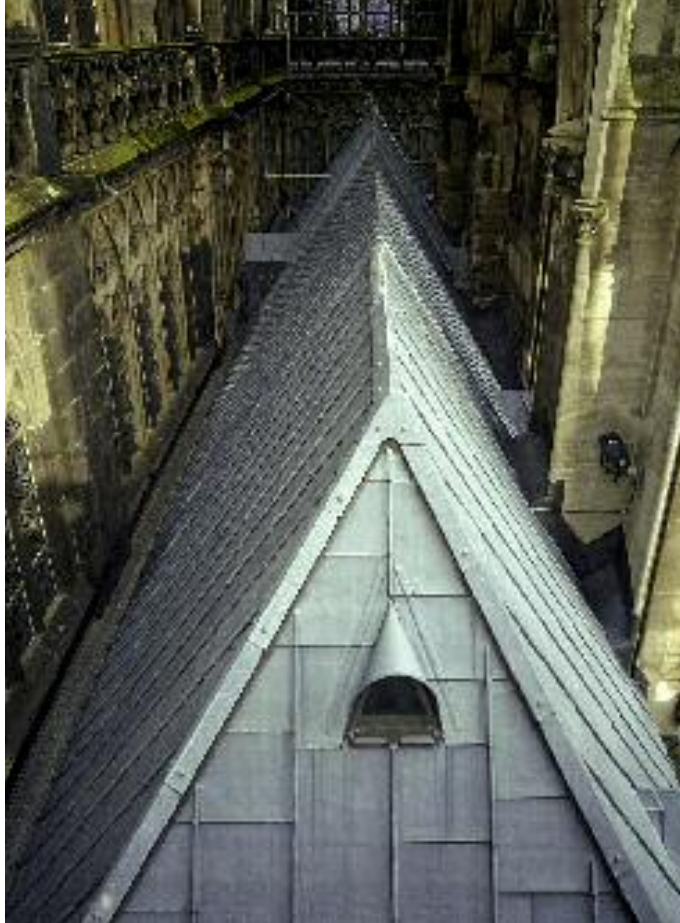
8. Neu eingedecktes Dach des östlichen Südquerhausseitenschiffes.
