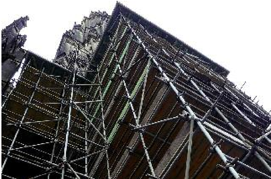
7. Das mit einem Holzdach versehene neue Gerüst an F 3.
