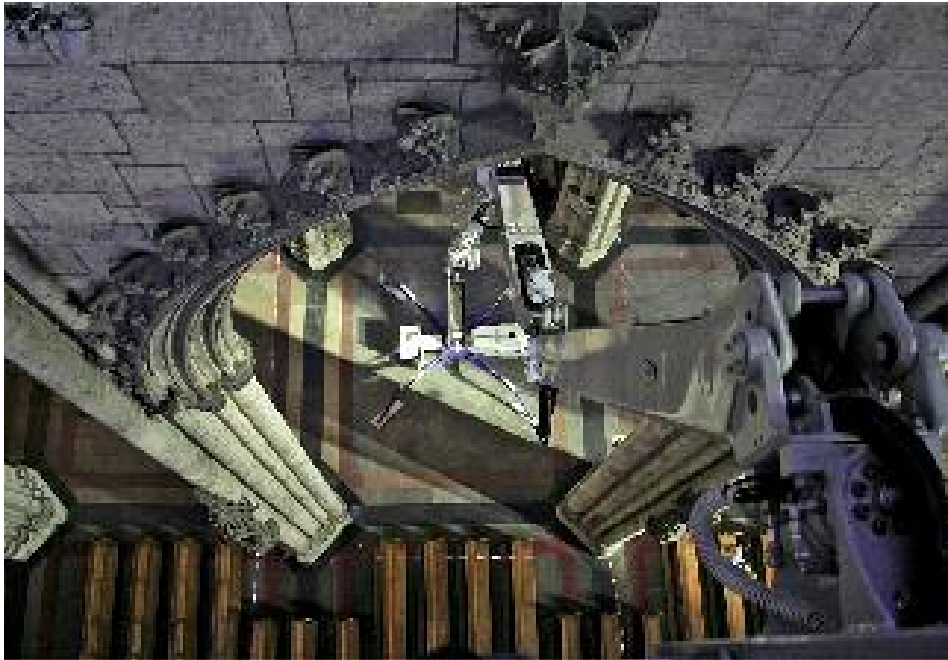
28. Aufmasarbeiten im Dominnenraum mit Hilfe des »Falken Spyder«.
