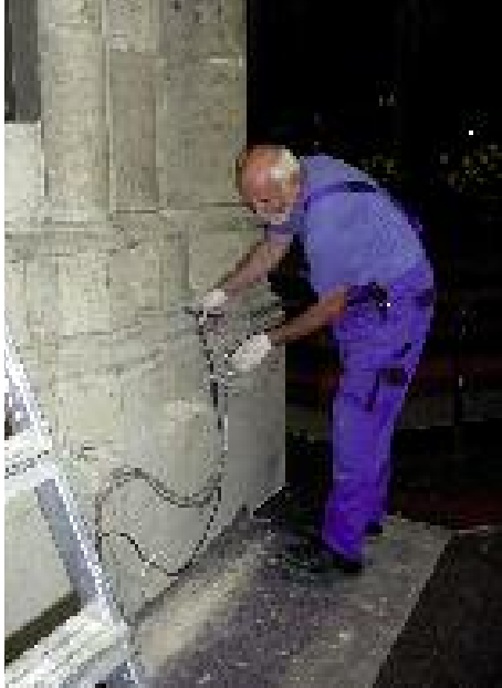
17. Elektriker Lothar Reinhardt beim Verlegen der Kabel für die neue Beschallungsanlage.
