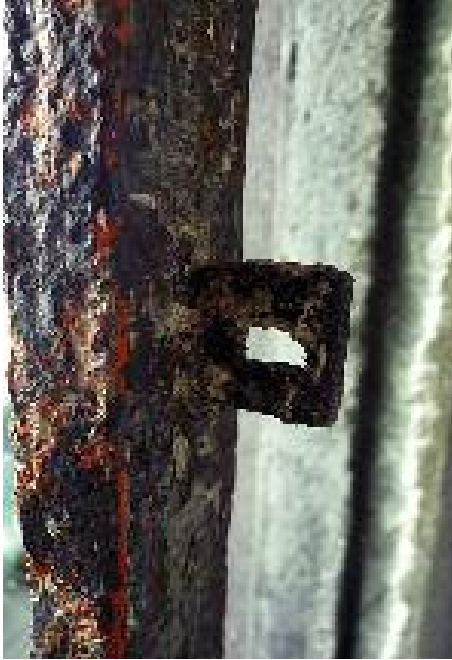
12. Mittelalterliche Eisennocke am Windeisen des Fensters S III.
