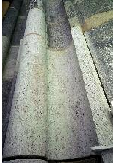
4. Saniertes Steinwerk an der Laibung des Chorobergadenfensters S IV.
