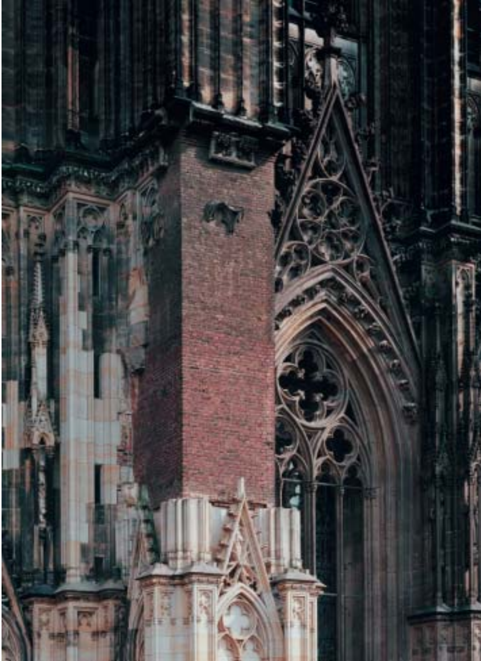
2. Ziegelplombe am Strebe Pfeiler F 1 des Nordturmes.
