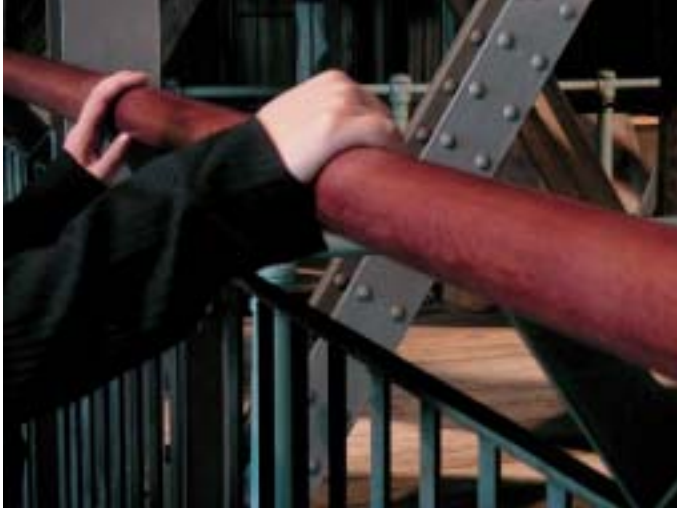
10. Neues Geländer mit Handlauf aus Merbau-Holz im Glockenstuhl des Südturmes.
