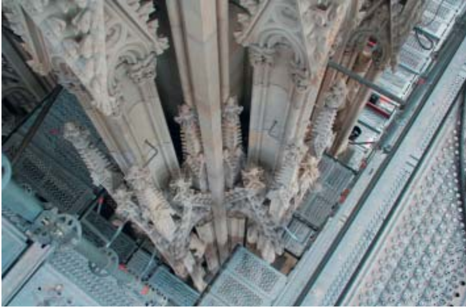
4. Neuversetzte Fialen und Kapitelle am Strebebögen F 1 des Nordturmes.
