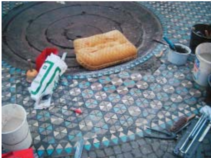
15. Fliesenbelag des Taubenbrunnens von Ewald Mataré vor der Westfassade des Domes während der Restaurierung.
