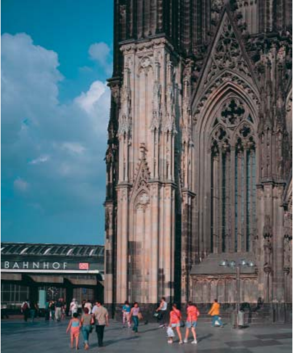
5. Die Neuverblendung der ehemaligen Ziegelplombe am Strebepeer F 1 des Nordturmes.
