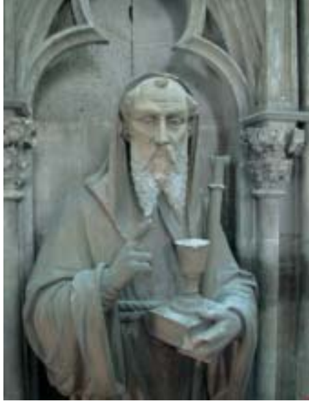
19. Restaurierter Kopf der Benediktfigur an der Fassadeninnenwand des Südquerhauses.
