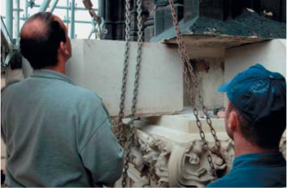
3. Versetzarbeiten am Strebepfeiler F 1 des Nordturmes.
