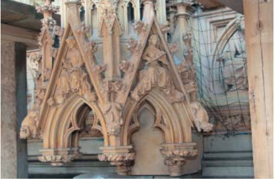
25. Mittelbaldachin des Marienportales in der Westfassade des Domes nach der Reinigung.
