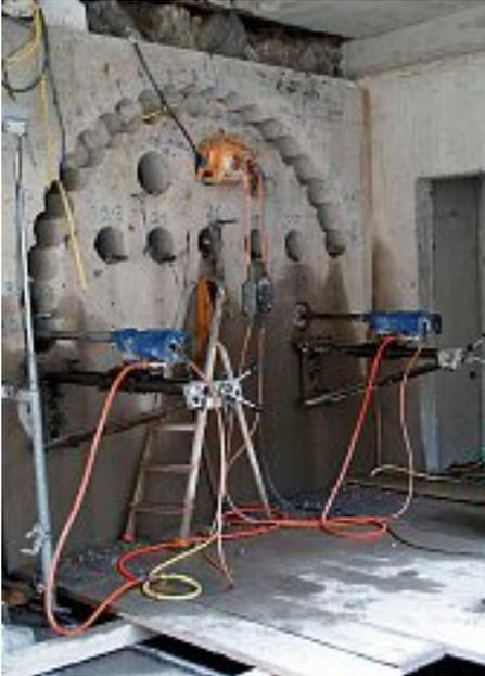
32. Bohrarbeiten am Fundament des Südturmes.
