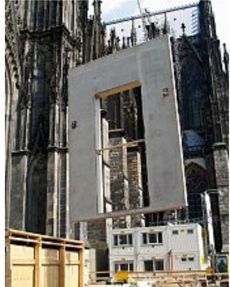
36. Einbau der aus Beton gegossenen Fertigbauteile für den neuen Kiosk.
