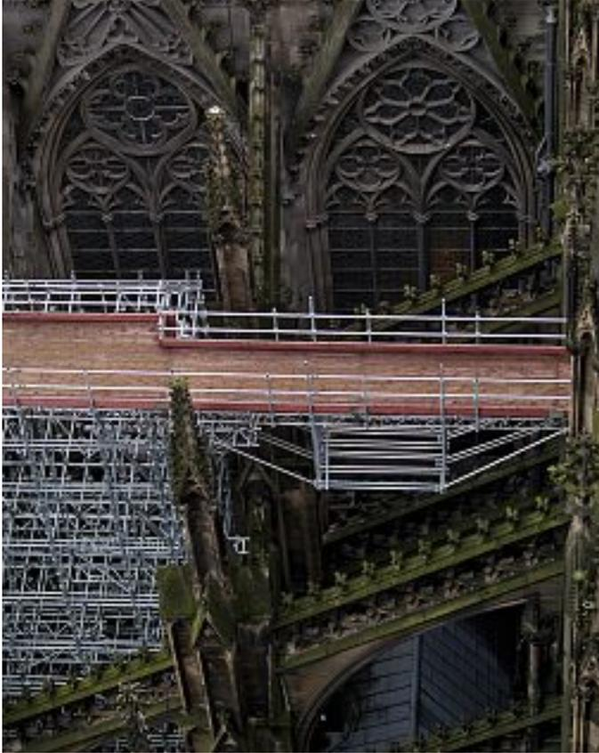
13. Die neue Gerüstbrücke zwischen Bauaufzug und hohem Dach.
