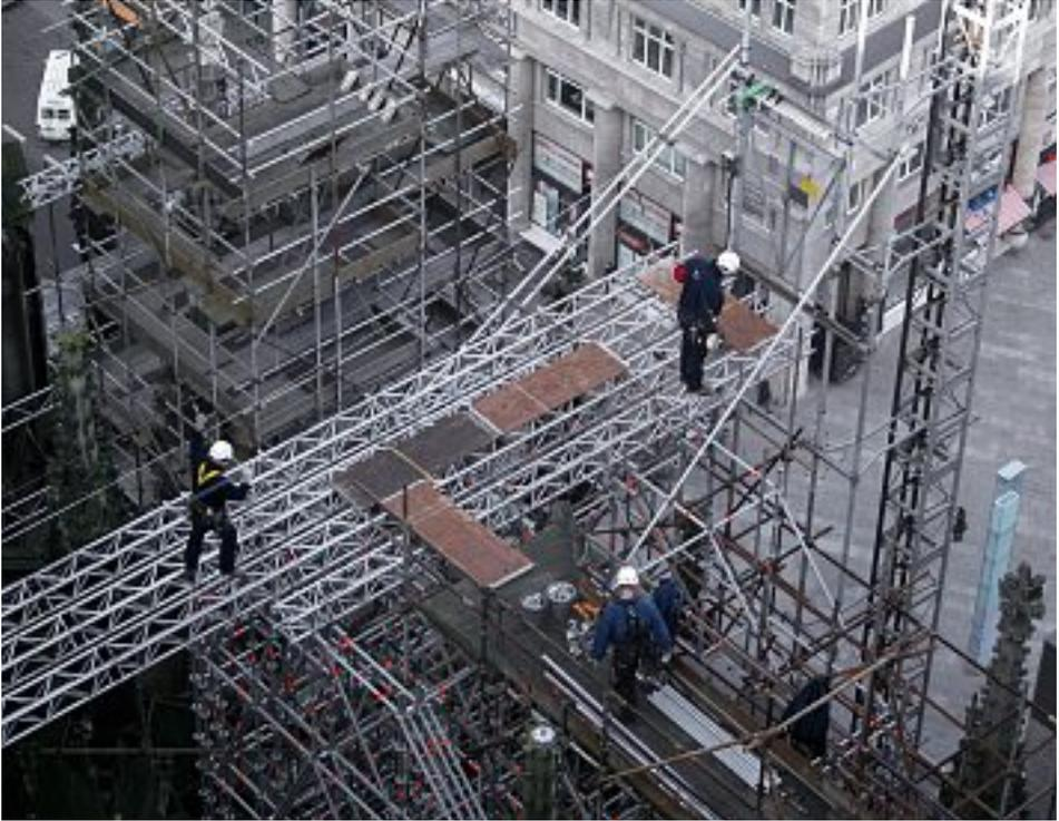
12. Die Gerüstbauer beim Bau der neuen Gerüstbrücke.
