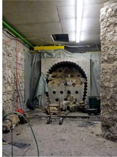
33. Ausbruch des Fundamentkerns mit hydraulischen Pressen.
